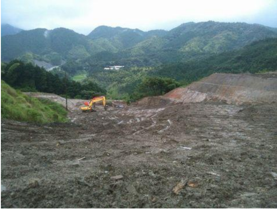
建設中のゲレンデ
